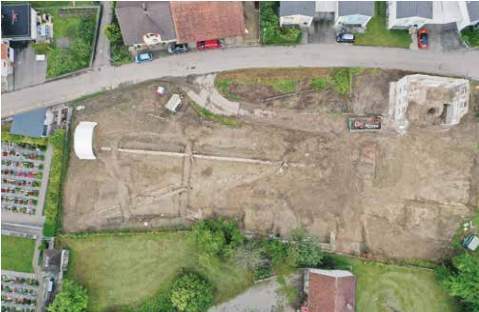
Abb. 3. Seengen-Schlattweg 2020 (See.020.6). Drohnenaufnahme mit Mauerbefunden der römischen villa rustica. Am rechten Bildrand sind unmittelbar östlich, d. h. im Bild unterhalb, der Reste des abgebrochenen Bauernhauses Reste der Thermenanlage zu erkennen. (Kantonsarchäologie Aargau).
