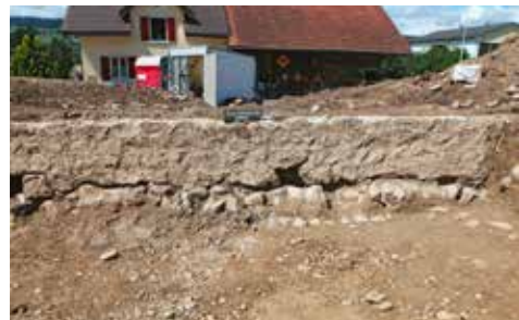
Abb. 4. Seengen-Schlattweg 2020 (See.020.6). Detailansicht der Hangstützmauer Pos. 5. Das sorgfältige Handquadermauerwerk weist einen pietra rasa-Verputz und Fugenstrich auf. (Kantonsarchäologie Aargau).
